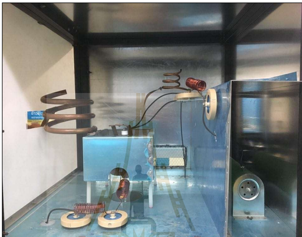
รูปที่ 3.14 การติดตั้งชุดวงจรกำเนิดสัญญาณความถี่วิทยุกำลังสูง
