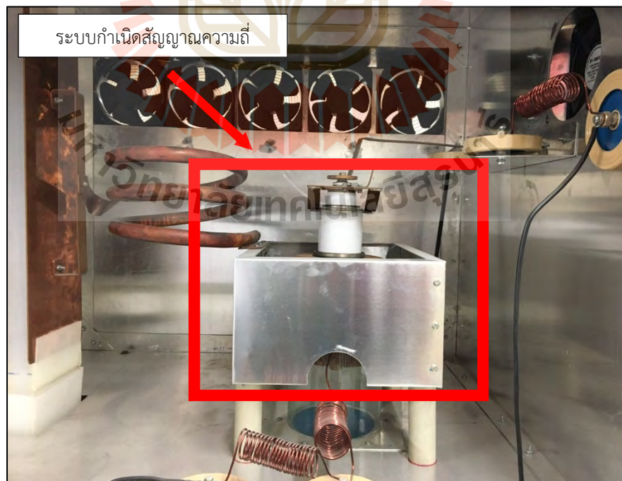
รูปที่ 3.63 การติดตั้งชุดวงจรกำเนิดสัญญาณความถี่วิทยุกำลังสูง
