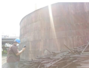
ภาพที่ 5 วัดความร้อนของถังเก็บน้ำคอนเดนเสท
