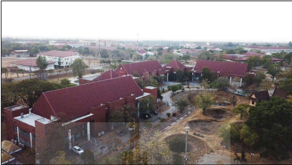
รูปที่ ก.9 หลังคาอาคารศูนย์เครื่องมือ 7
