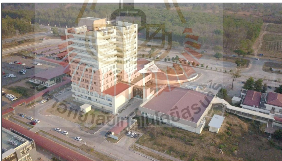
รูปที่ ก.2 หลังคาอาคารรัตนเวชพัฒน์ และศูนย์รังสีวินิจฉัย
