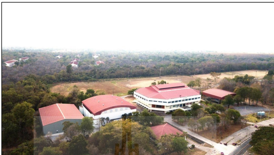
รูปที่ ก.11 หลังคาอาคารกีฬาภิรมย์
