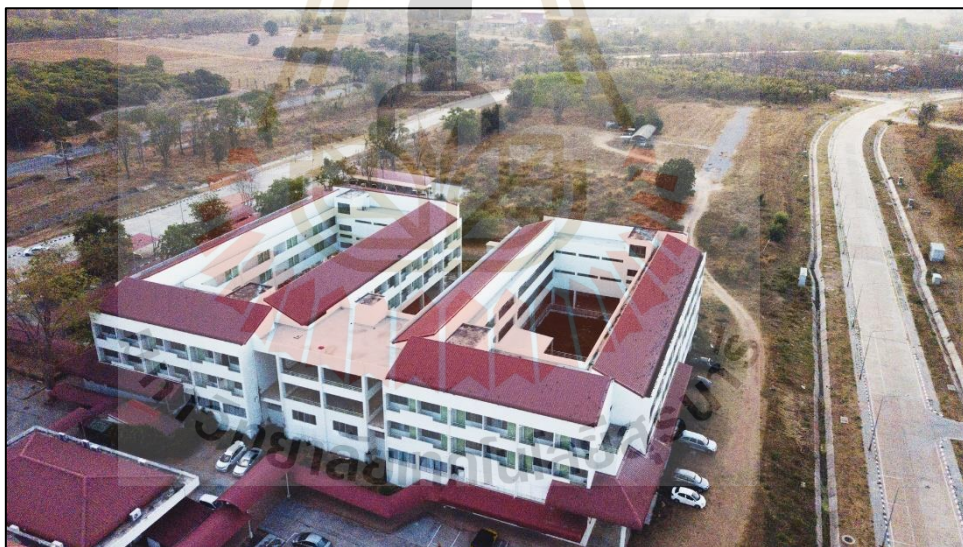
รูปที่ ก.14 หลังคาอาคารหอพัก 18
