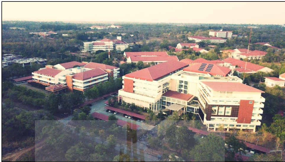
รูปที่ ก.13 หลังคาอาคารศูนย์เครื่องมือ 10 และ 11
