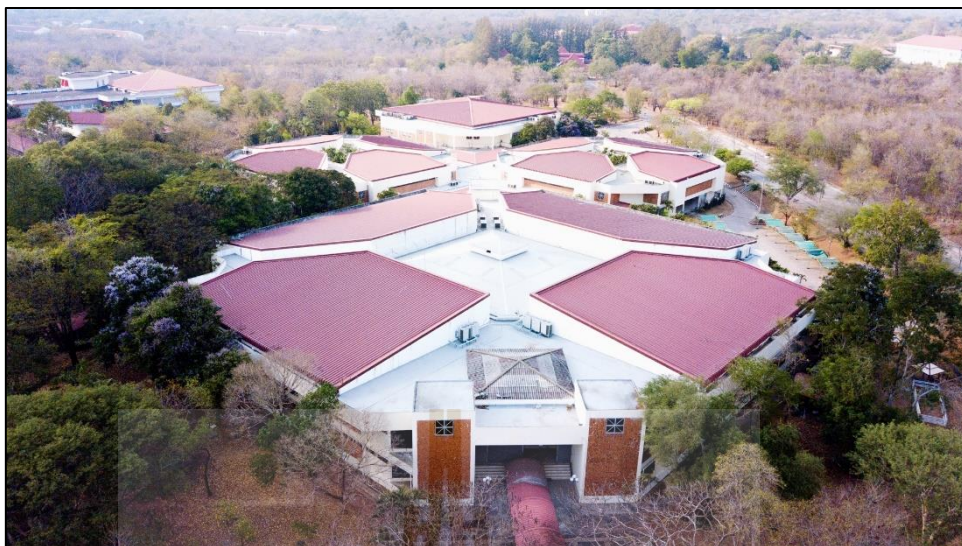
รูปที่ ก.5 หลังคาอาคารเรียนรวม 1
