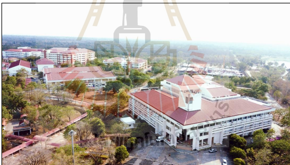
รูปที่ ก.6 หลังคาอาคารบรรณสาร
