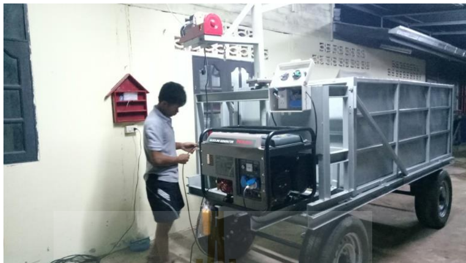
รูปที่ ง.3 ติดตั้งอุปกรณ์ไฟฟ้าลงเครื่องต้นแบบ
