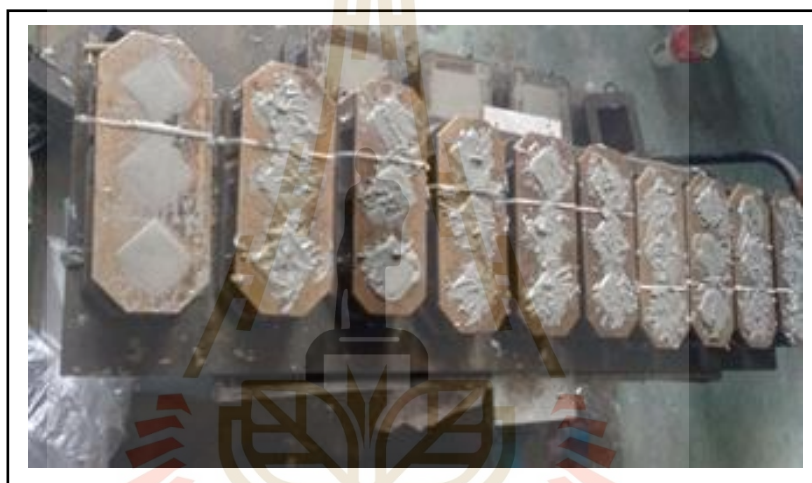
รูปที่ 3.15 คอนกรีตสดที่ถูกเทลงในแบบหล่อ
