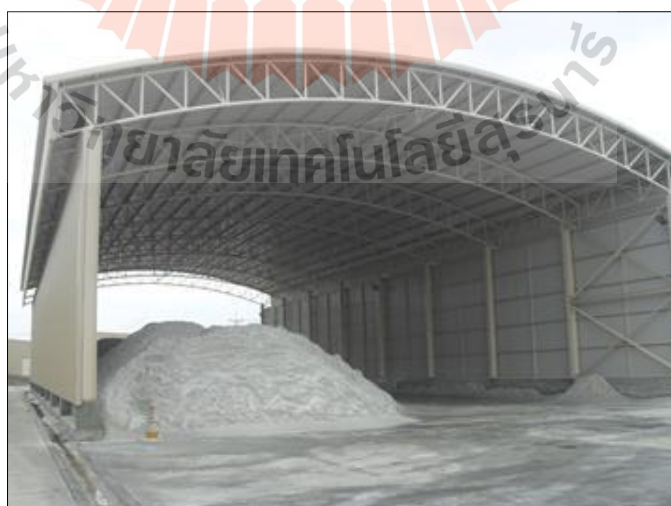
รูปที่ 2.42 แร่ยิปซัมไว้ในโกดังที่มีหลังคาจะป้องกันความชื้นจากภายนอกเข้ามาได้มาก
