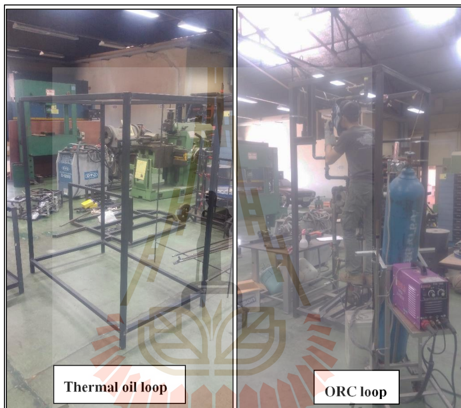
รูปที่ 3.16 การขึ้นโครงสร้างโรงไฟฟ้าของ ORC loop และ thermal oil loop
