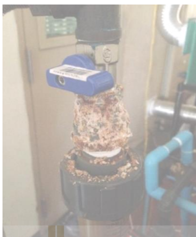
รูปที่ 3.6 การกัดกร่อนของสารดูดความชื้น
