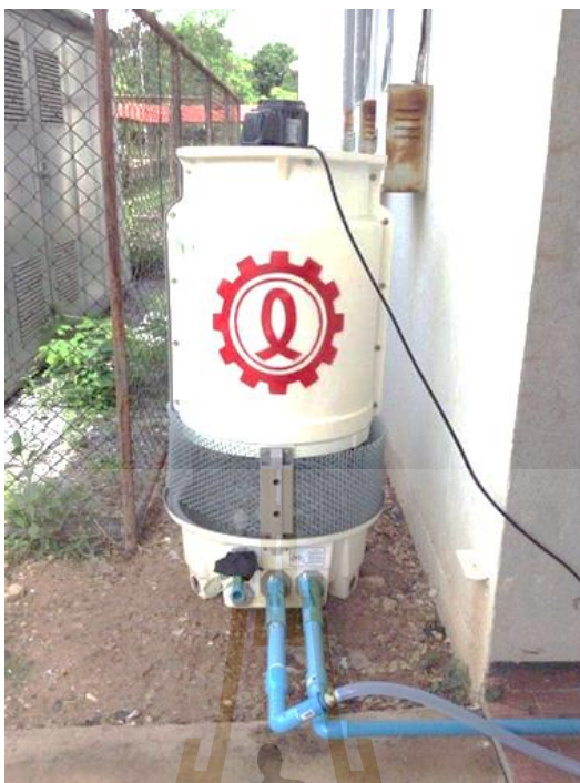
รูปที่ 4.11 การติดตั้ง cooling tower เพื่อลดอุณหภูมิสารดูดความชื้น
