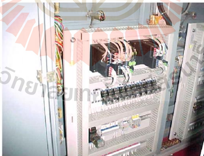
รูปที่ 3.15 อุปกรณ์ควบคุมการตัดตอนระยะไกล
