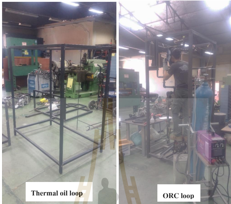
รูปที่ 3.11 การขึ้นโครงสร้างโรงไฟฟ้าของ ORC loop และ thermal oil loop
