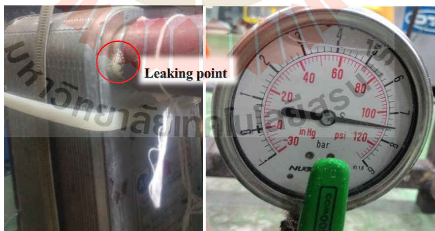
รูปที่ 3.12 การทดสอบการรั่วโดยการอัดอากาศในระบบท่อ
