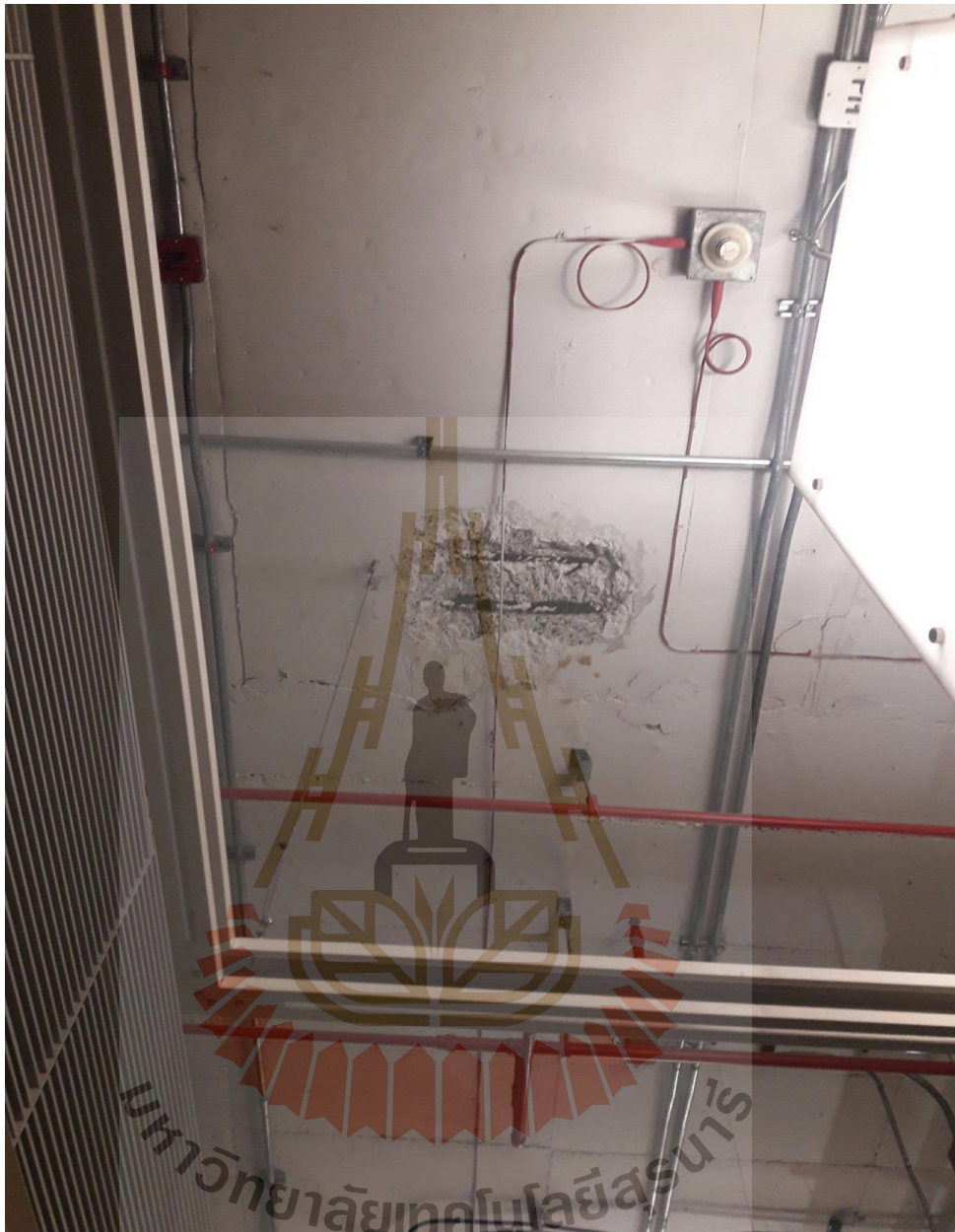
รูปที่ ก.5 รอยแตกร้าวบริเวณกว้าง ทำการสกัดคอนกรีตจนถึงเนื้อคอนกรีตที่ แข็งแรงอาจต้องสกัดคอนกรีตจนถึงแนวเหล็กเสริมคอนกรีต
