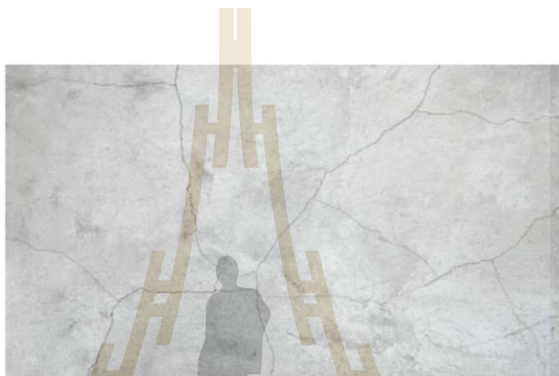
รูปที่ 2.10 การแตกร้าวแบบ Plastic Shrinkage Crack (ที่มา : Cr. Concrete Technology C-PAC)
