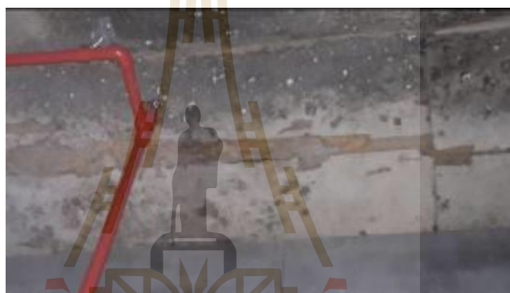
รูปที่ 4.6 การสำรวจพบรอยร้าวในคานเนื่องจากเหล็กเสริมเป็นสนิม จำนวน 44 จุด
