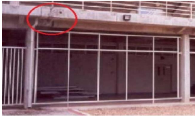
(จ) ภาพการแตกร้าวแบบยี่ดิ่งภายนอกที่เกิดขึ้นจริง
