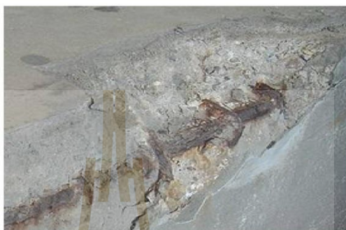
รูปที่ 2.4 การเกิดปฏิกิริยาคาร์บอนไดออกไซด์ ที่ทำให้คอนกรีตเกิดสนิม (ที่มา: Principles & Practice, 2001)
