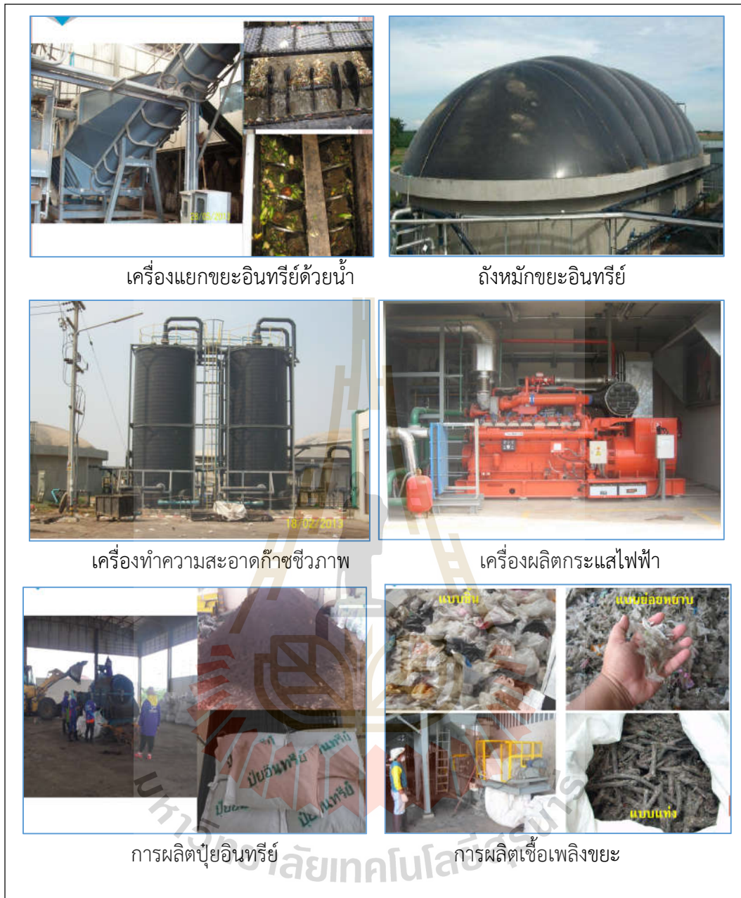
ภาพที่ 2.8 ระบบผลิตกระแสไฟฟ้าจากขยะมูลฝอย เทศบาลนครนครราชสีมา ที่มา: รายงานการฝึกอบรมและศึกษาดูงานเกี่ยวกับเทคโนโลยีและการจัดการขยะมูลฝอย.
