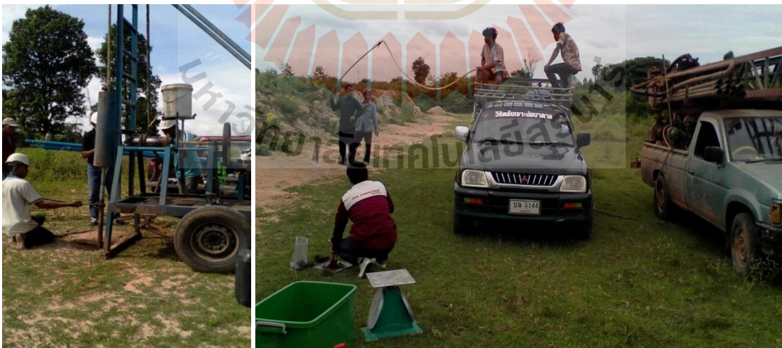
รูปที่ 3.10 การเจาะสำรวจและเก็บตัวอย่างชั้นดิน
