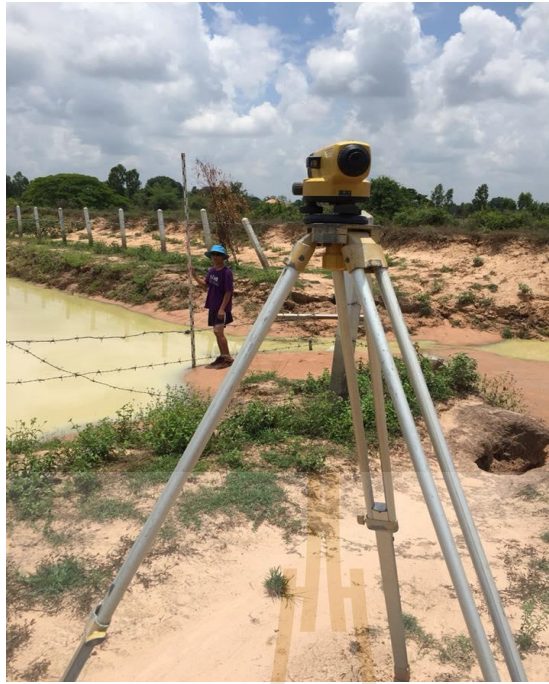
รูปที่ 3.8 การทำระดับวงรอบ
