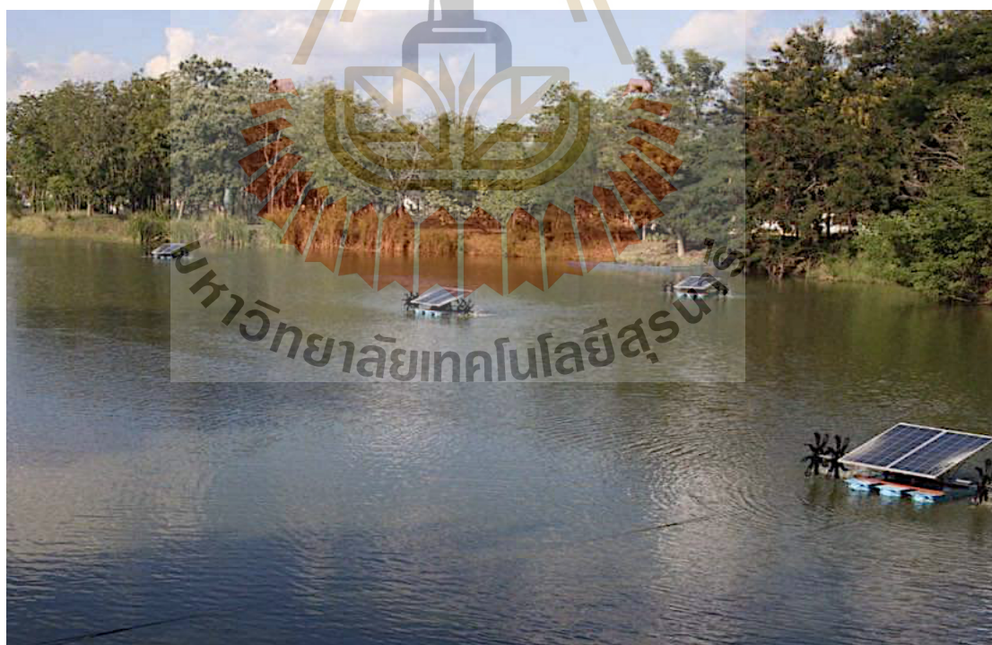
รูปที่ 5.20 ชุดเติมอากาศกังหันตีน้ำด้วยพลังงานแสงอาทิตย์ 10 ชุด
