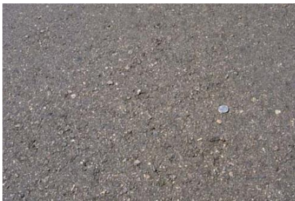
รูปที่ 2.7 การสึกกร่อนของผิวทาง (Raveling) [13]
