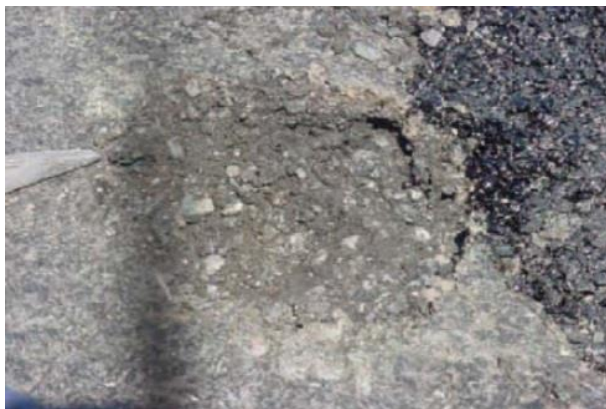
รูปที่ 2.8 การแตกร้าวและนำไปสู่การหลุดลอกของผิวทาง (Stripping) [13]
