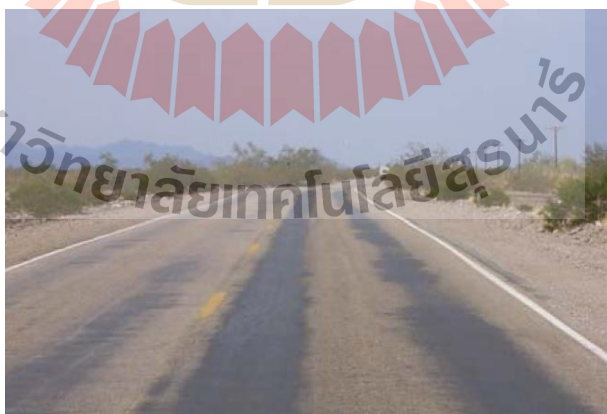
รูปที่ 2.3 การไหลเยิ้มของวัสดุแอสฟัลต์บนผิวทาง (Bleeding) [13]
