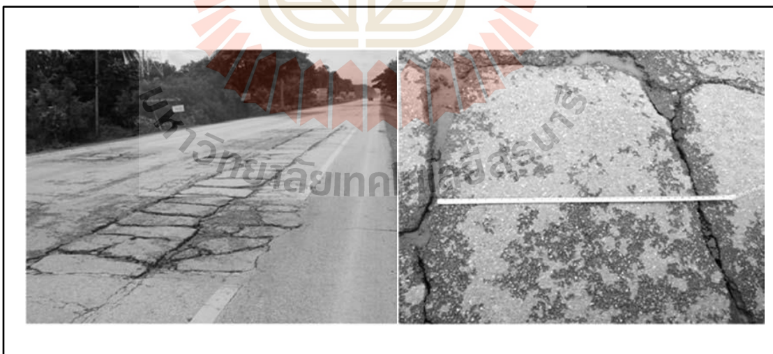
รูปที่ 2.3 ตัวอย่างการแตกร้าวของการใช้วัสดุผสมซีเมนต์เป็นพื้นทาง (วสันต์ ปั่นสังข์ และคณะ, 2553)
