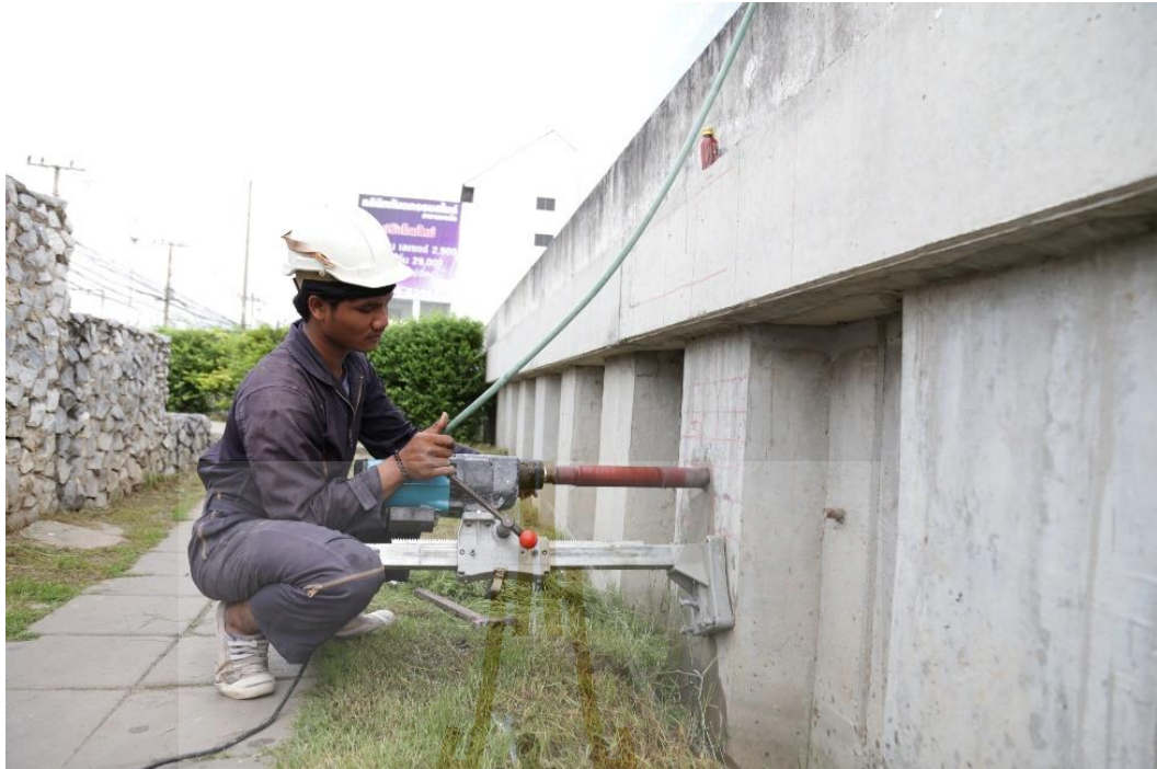
รูปที่ 3.5 การเก็บตัวอย่างคอนกรีตด้วยเครื่อง Core Drilling Machine
