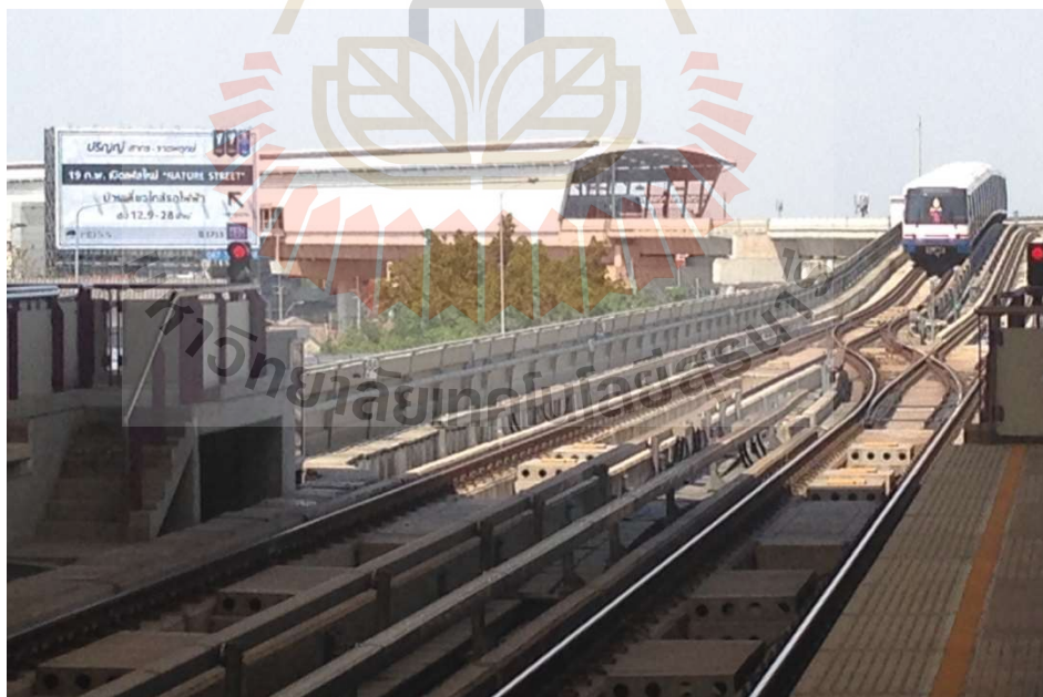
รูปที่ 6.56 เส้นทางเดินรถเปลี่ยนทางวิ่งที่สถานีผู้โดยสาร S12 (บางหว้า)
