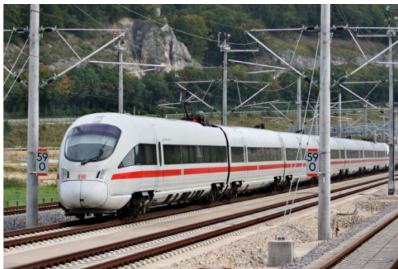
รูปที่ 3.5 รถไฟฟ้าแบบใช้ระบบจ่ายไฟฟ้า 25 kVac แบบใช้สายส่งเหนือศีรษะที่ประเทศเยอรมัน ที่มาภาพ : http://pictures.4ever.eu/tag/26102/high-speed-train?pg=2 [เข้าถึงเมื่อ 16 ก.ย. 2560]
