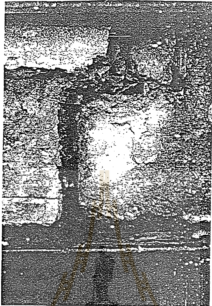
รูปที่ 2.6 รอยร้าวที่ขอบคานเกิดจากความไม่มีคุณภาพในการถอดไม้แบบ
