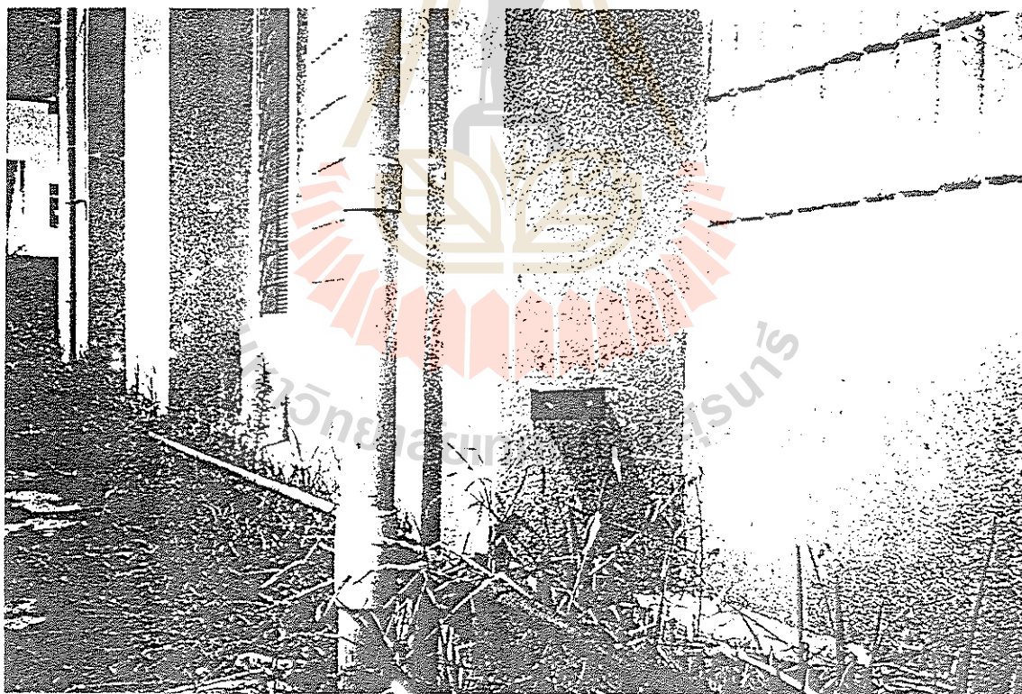
รูปที่ ง-4 การติดเหล็กฉากที่เสาอาคาร เพื่อใช้วางไม้วัดระดับในการวัดการทรุดตัวของฐานราก
