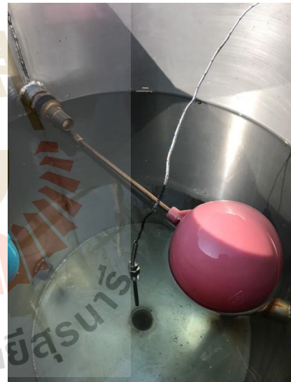
(ข) การติดตั้งวาล์วลูกลอยในถังเก็บน้ำร้อน
