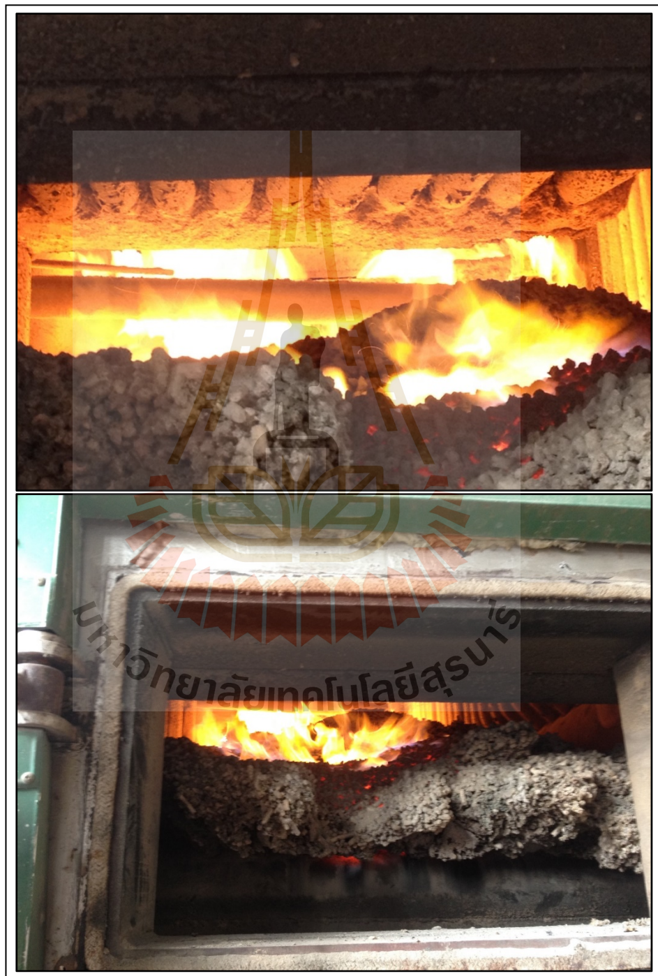
รูปที่ 4.29 ลักษณะภายในเตาและตำแหน่งอุปกรณ์เก็บการกักความร้อนในหม้อไอน้ำ
