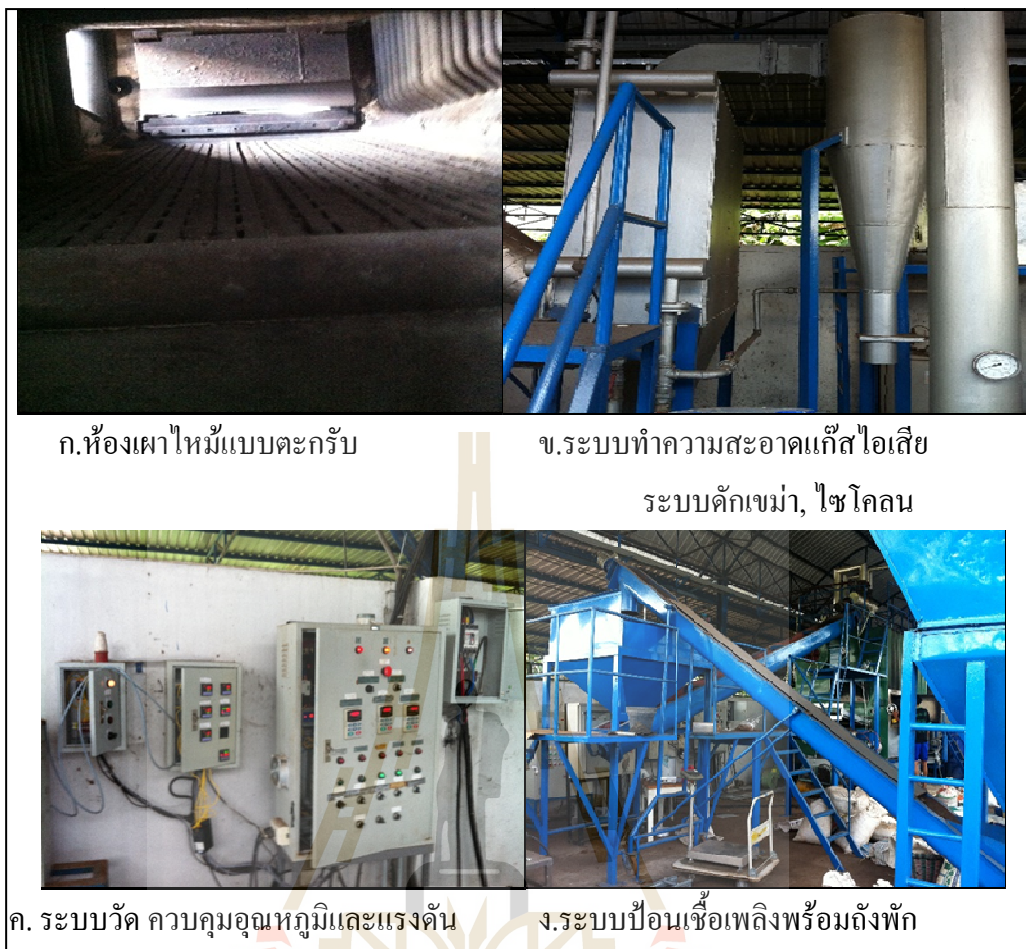
รูปที่ 3.9 ระบบผลิตพลังงานความร้อนของหม้อไอน้ำ
