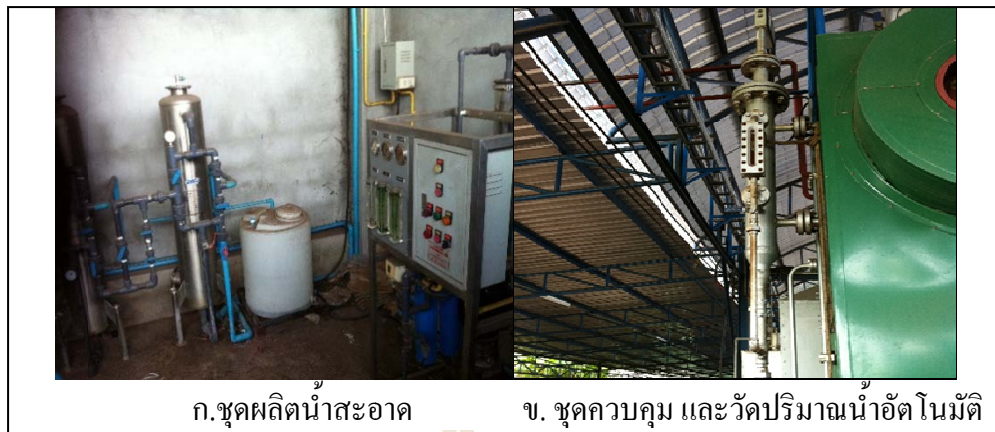
รูปที่ 3.10 ระบบการผลิตและใช้ไอน้ำ
