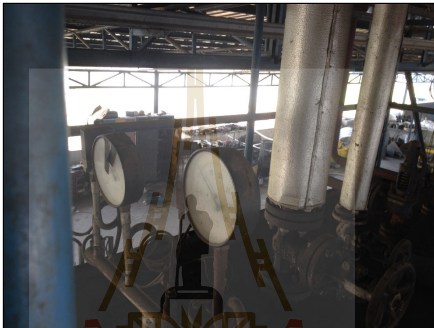
รูปที่ 4.12 เกจวัดแสดงแรงความดันในหม้อต้มไอน้ำ
