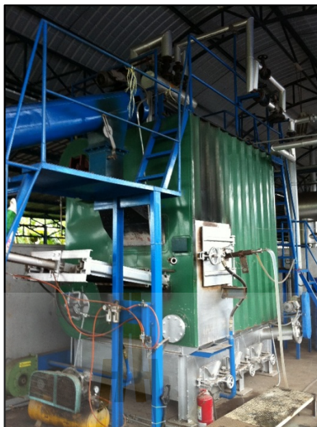
รูปที่ 3.8 หม้อต้มไอน้ำชนิดท่อน้ำ
