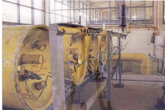
รูปที่ 2.9 การเติมคลอรีนแก๊สในการฆ่าเชื้อโรค (สำนักบริหารจัดการน้ำ http://www.prapathai.com )
