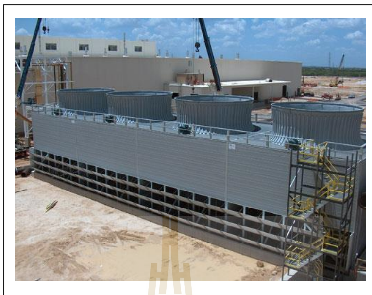
รูปที่ 1.4 การประยุกต์ใช้วัสดุ FRP สำหรับหอทำความเย็น (Creative Pultrusions, 2004)
