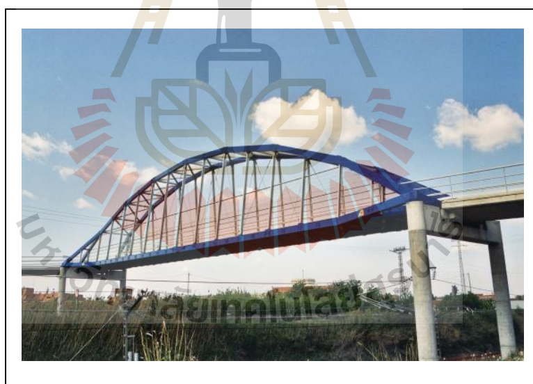
รูปที่ 1.5 การใช้วัสดุ FRP สำหรับสะพานข้ามทางรถไฟ (Pedelta Structural Engineers, 2010)
