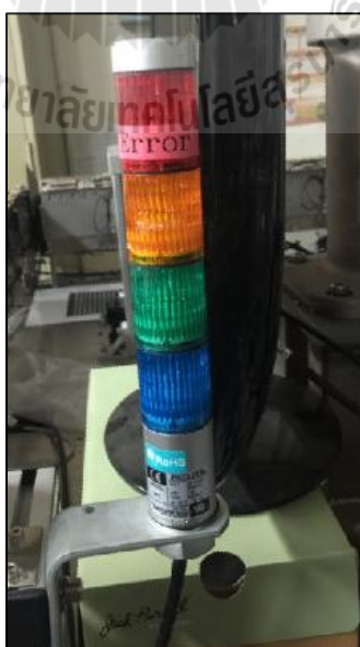
รูปที่ 3.18 แสดงทำการติดตั้งไฟแจ้งสถานะ
