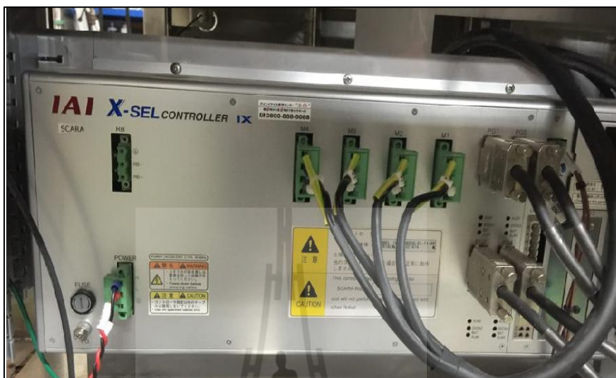
รูปที่ 3.13 แสดงการติดตั้งการควบคุม Robot
