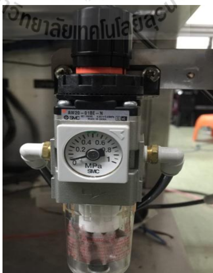
รูปที่ 3.16 แสดงการติดตั้ง Main Regulator
