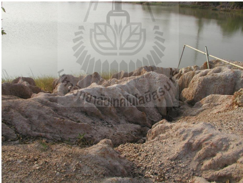
รูปที่ 1-1 การถูกกัดเซาะของคันดินรอบอ่างเก็บน้ำในบริเวณ ตำบลโคกกรวด อำเภอเมือง จัง
