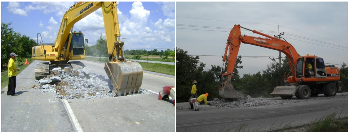
รูปที่ 1.2 การขุดรื้อถนนเก่า
