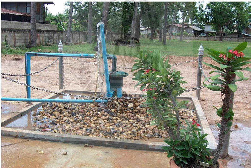
ภาพที่ 2.5 บ่อน้ำบาดาลความดัน (Artesian well)
