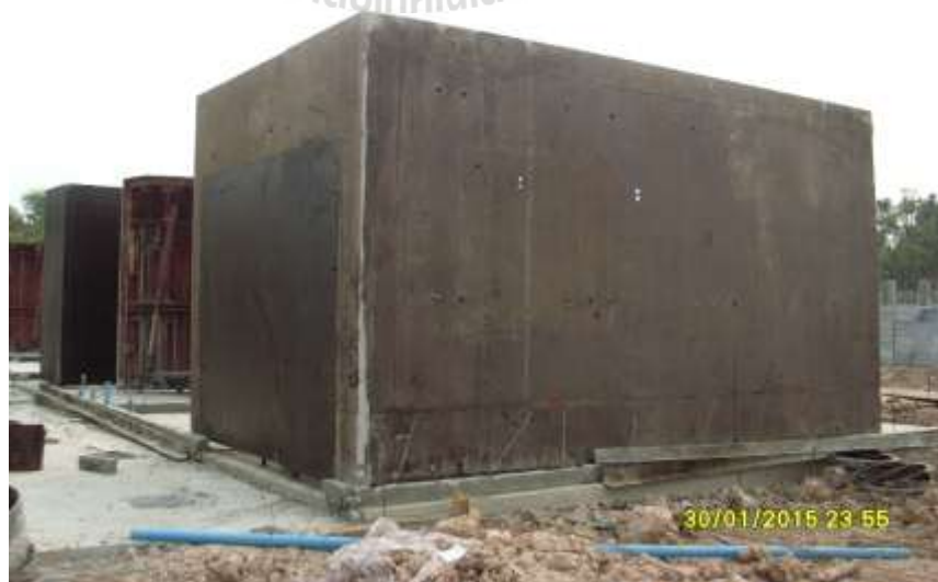
รูปที่ 2.14 การเทคอนกรีตลงใน Tunnel Form (The Connect 28 เพิ่มสิน – วัชรพล)
