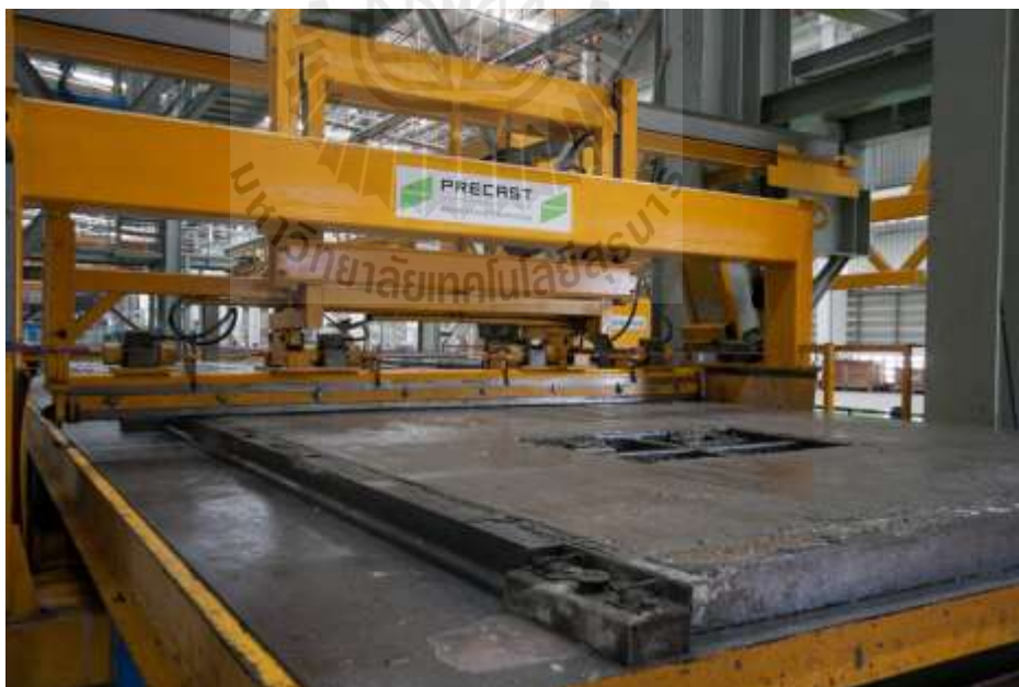
รูปที่ 2.8 การเทคอนกรีต (Pruksa Real Estate , 2015)
