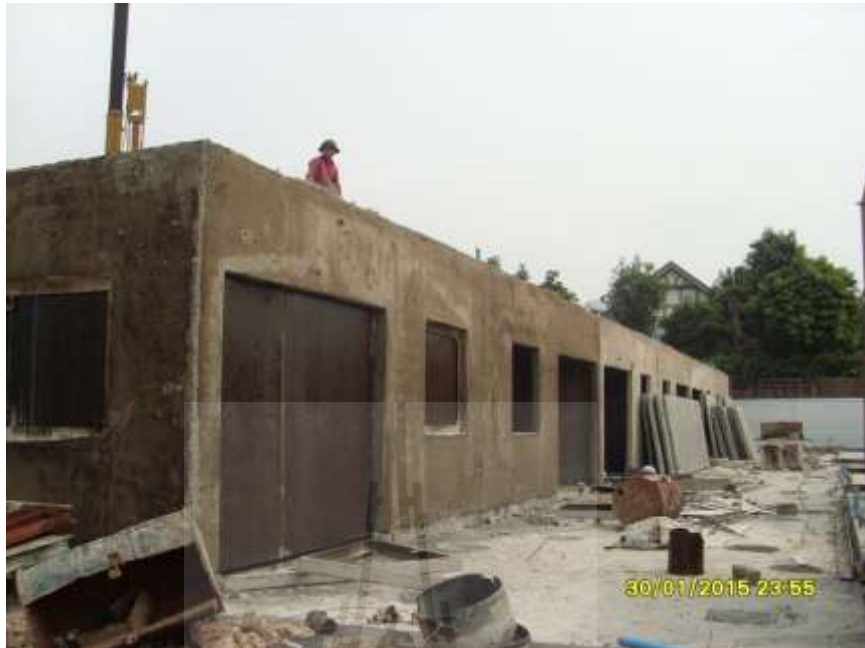
รูปที่ 3.2 บ้าน Type A (พื้นที่ใช้สอย 145 ตรม.) โดยวิธีการหล่อในที่
