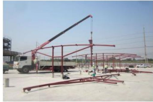
เริ่มการติดตั้งโครงหลังคาเหล็ก โรงจอดรถ
