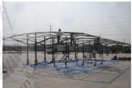
การติดตั้งตัวแปรง โครงหลังคาเหล็ก
