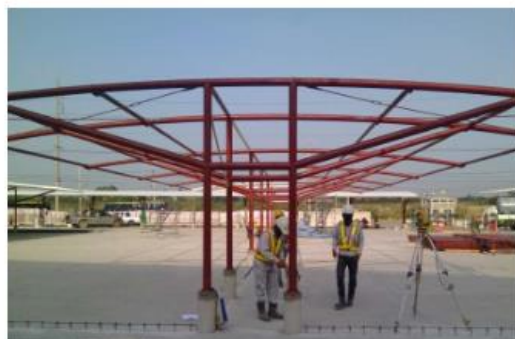
การติดตั้งตัวยึดโครงหลังคาเหล็กพร้อมทั้งปรับระดับ
