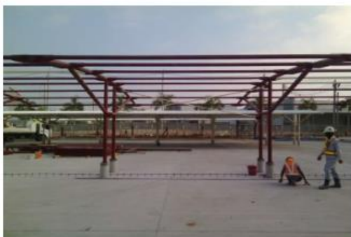
การติดตั้งตัวยึดโครงหลังคาเหล็ก
