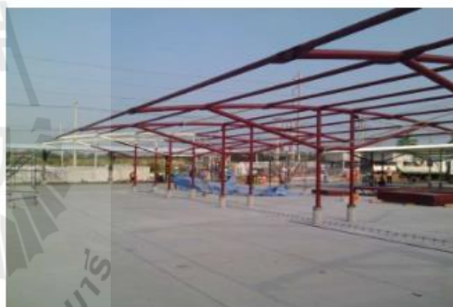
การติดตั้งตัวแปรโครงหลังคาเหล็ก หลังจากแก้ไขโครงเหล็กให้ถูกต้องแล้ว
