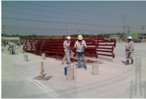
การเตรียมงานการติดตั้ง
