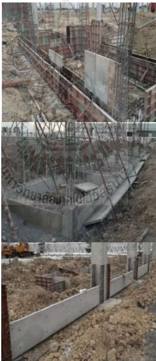
รูปที่ 4.4 กิจกรรมงานคานคอดิน
