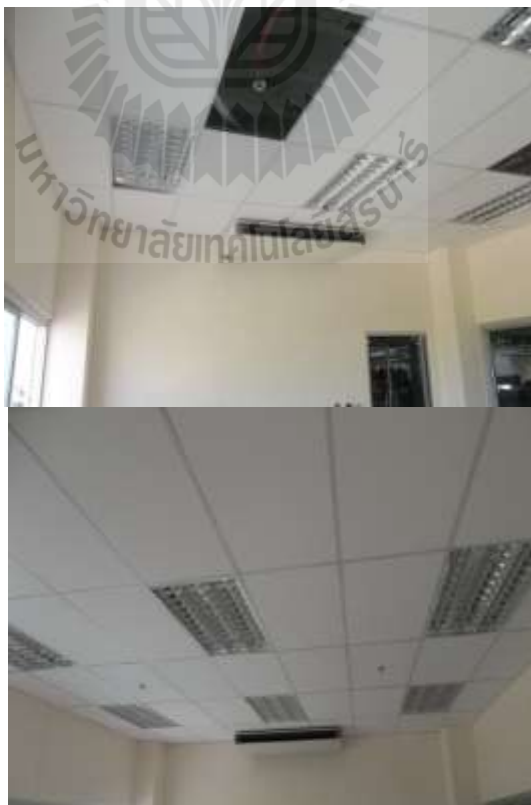
รูปที่ 4.13 กิจกรรมงานติดตั้งฝ้าเพดาน
