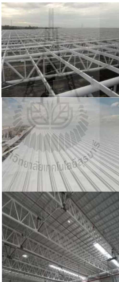
รูปที่ 4.9 กิจกรรมงานติดตั้งแผ่นหลังคา
