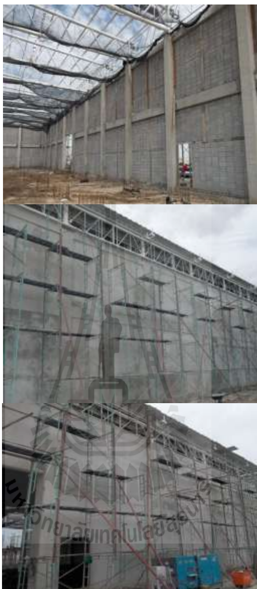
รูปที่ 4.10 งานก่ออิฐผนังและฉาบปูนผนัง
