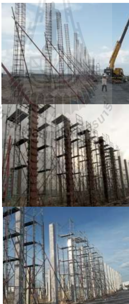
รูปที่ 4.5 กิจกรรมงานเสาคอนกรีต
