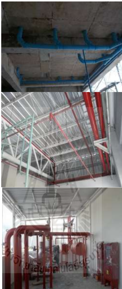
รูปที่ 4.15 กิจกรรมงานระบบสุขาภิบาลและระบบดับเพลิง
