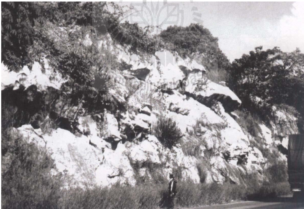
รูปที่ 6.2 ความลาดเอียงของมวลหินบริเวณหลักกิโลเมตรที่ 136 บนทางหลวงสายมิตรภาพ เขตอำเภอมวกเหล็ก จังหวัดสระบุรี (กิตติเทพ เฟื่องขจร, 2546)
