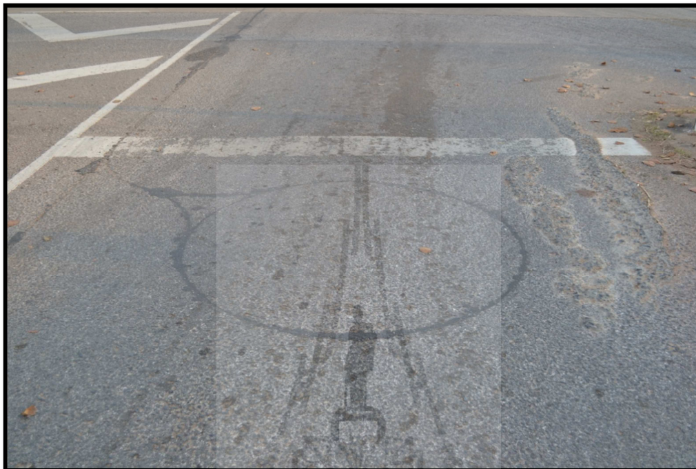
รูปที่.4.17 ลูปเหนี่ยวนำที่ติดตั้งที่พื้นถนน
