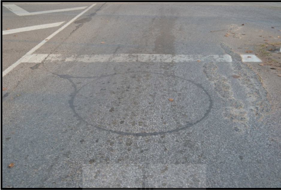
รูปที่.3.35 การติดตั้งลูปเหนี่ยวนำที่พื้นถนน
