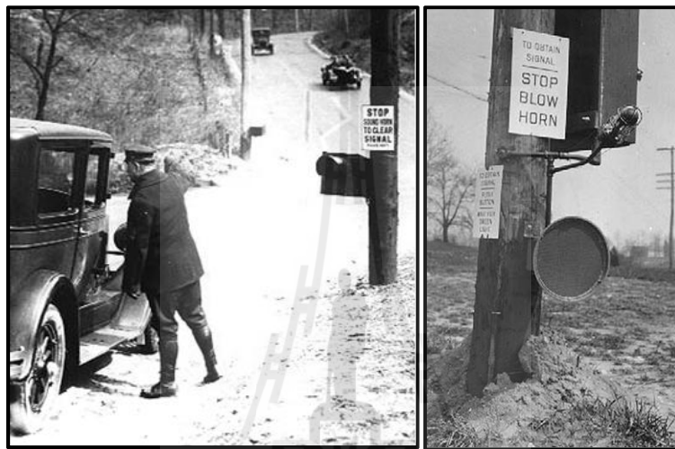
รูปที่.2.9 การตรวจวัดยานพาหนะโดยใช้ Micro Phone
