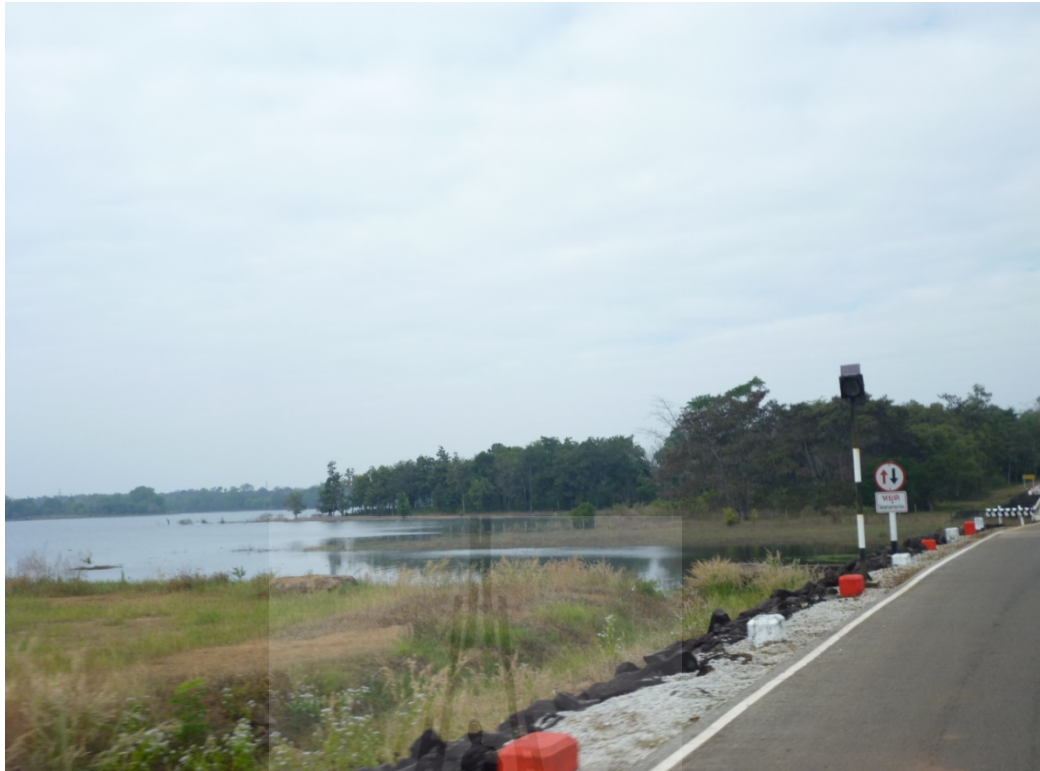
รูปที่ 3-3 จุดที่ 1 บริเวณฝายน้ำล้นทางเข้าเขื่อน
