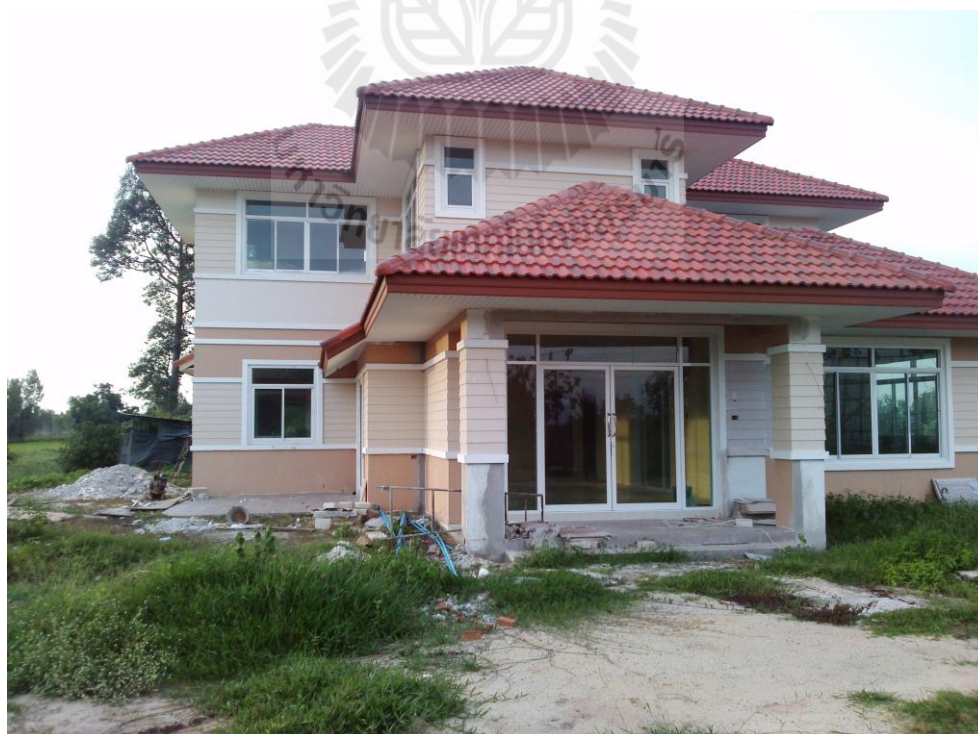
รูปที่ 1.3 อาคารพักอาศัยที่กำลังก่อสร้างในเขตตำบลโบสถ์
