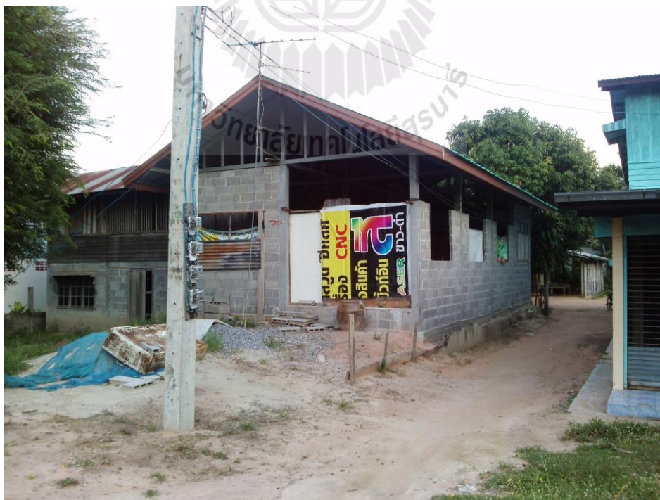
รูปที่ 1.5 อาคารพักอาศัยที่กำลังก่อสร้างในเขตตำบลโบสถ์
