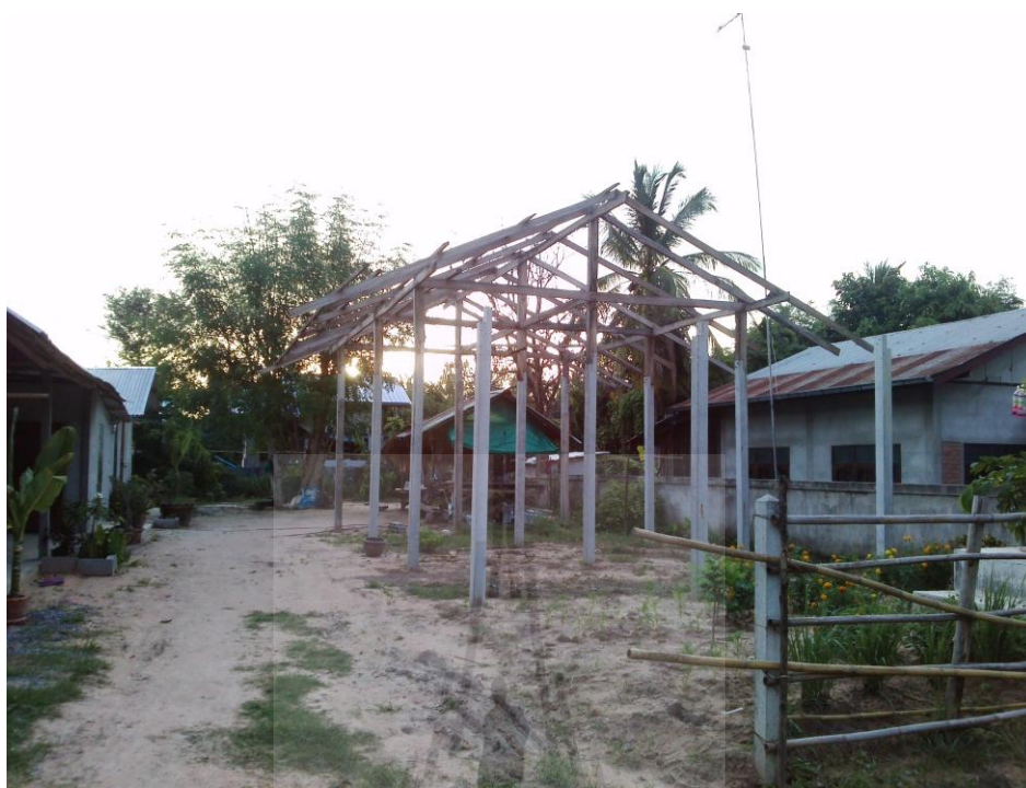
รูปที่ 1.4 อาคารพักอาศัยที่กำลังก่อสร้างในเขตตำบลโบสถ์
