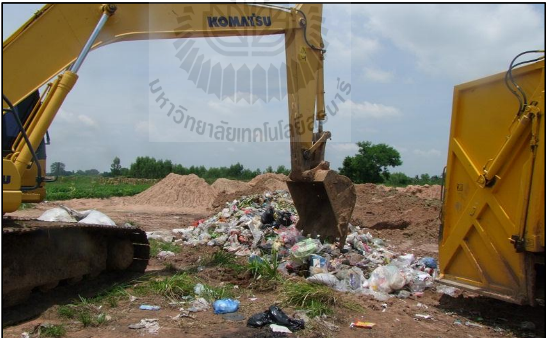
รูปที่ 3.4 สถานที่ฝังกลบขยะหมู่ที่ 9 บ้านดอนแซะ มีขนาดพื้นที่ 40 ไร่
