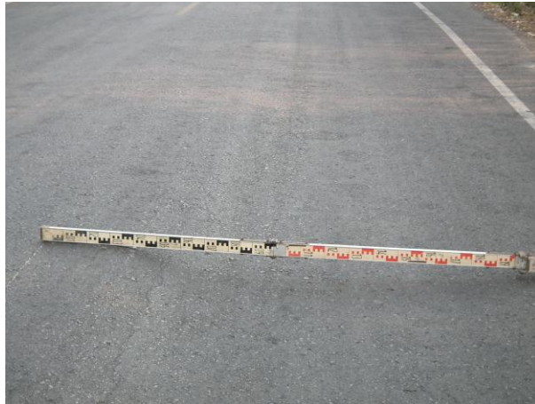
รูปที่ 4.5 การยวบตัวเป็นแอ่ง
