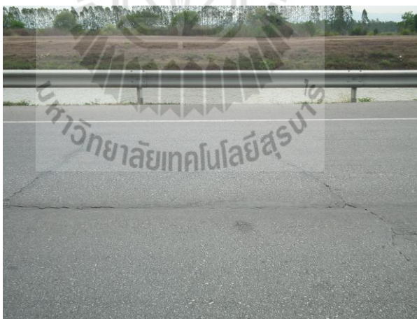
รูปที่ 4.2 รอยแตกเป็นตารางหรือรอยแตกจากการหดตัว
