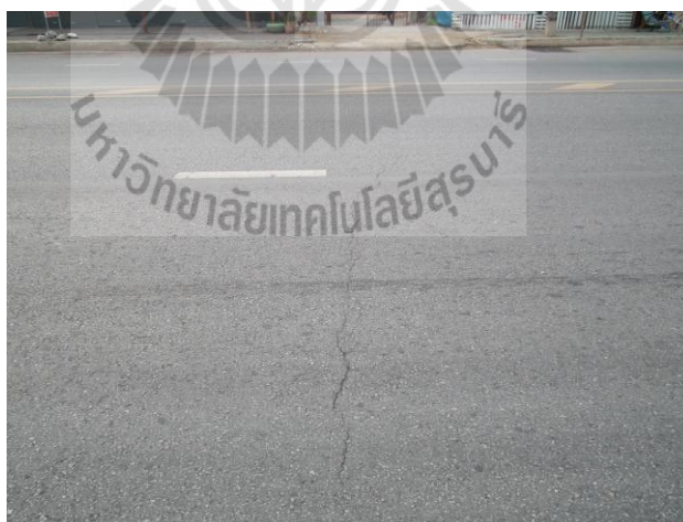
รูปที่ 4.8 รอยแตกตามขวางและรอยแตกตามแนวทแยงมุม
