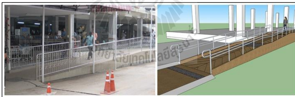
รูปที่ 4.36 เปรียบเทียบลักษณะของทางลาดด้านหน้าอาคารก่อนปรับปรุง (ซ้าย) และข้อเสนอแนะในการปรับปรุง (ขวา)
