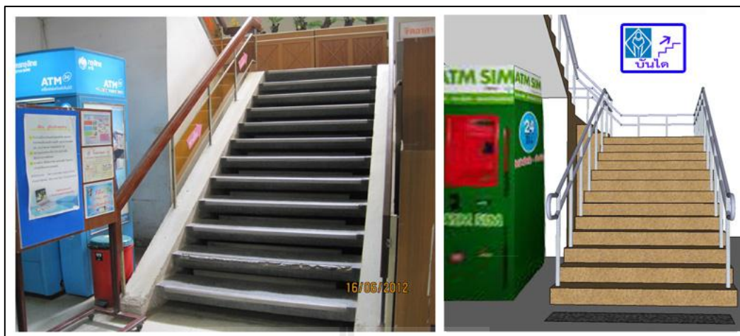
รูปที่ 4.41 เปรียบเทียบลักษณะของบันไดด้านหน้าอาคารก่อนปรับปรุง (ซ้าย) และข้อเสนอแนะในการปรับปรุง (ขวา)
