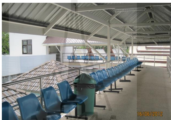
รูปที่ 4.32 ทางสัญจรชั้นบน จากลิฟต์มายังอาคารผู้ป่วยนอก
