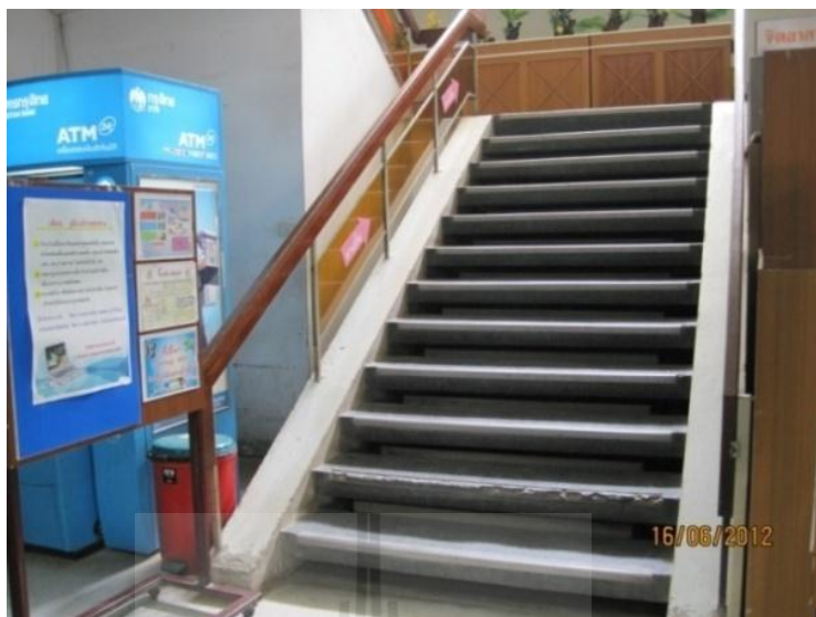
รูปที่ 4.14 บันไดด้านหน้าอาคาร
