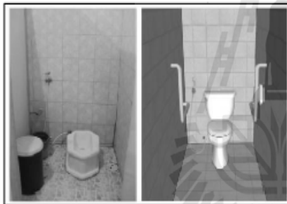
รูปที่ 5 เปรียบเทียบห้องส้วมก่อนปรับปรุง (ซ้าย) และข้อเสนอแนะในการปรับปรุง (ขวา)
