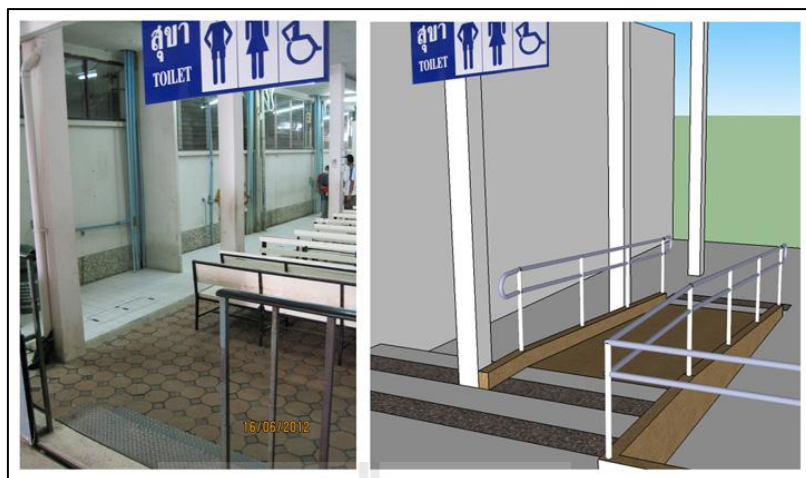
รูปที่ 4.40 ลักษณะของทางลาดสู่ห้องน้ำด้านหน้าอาคาร
