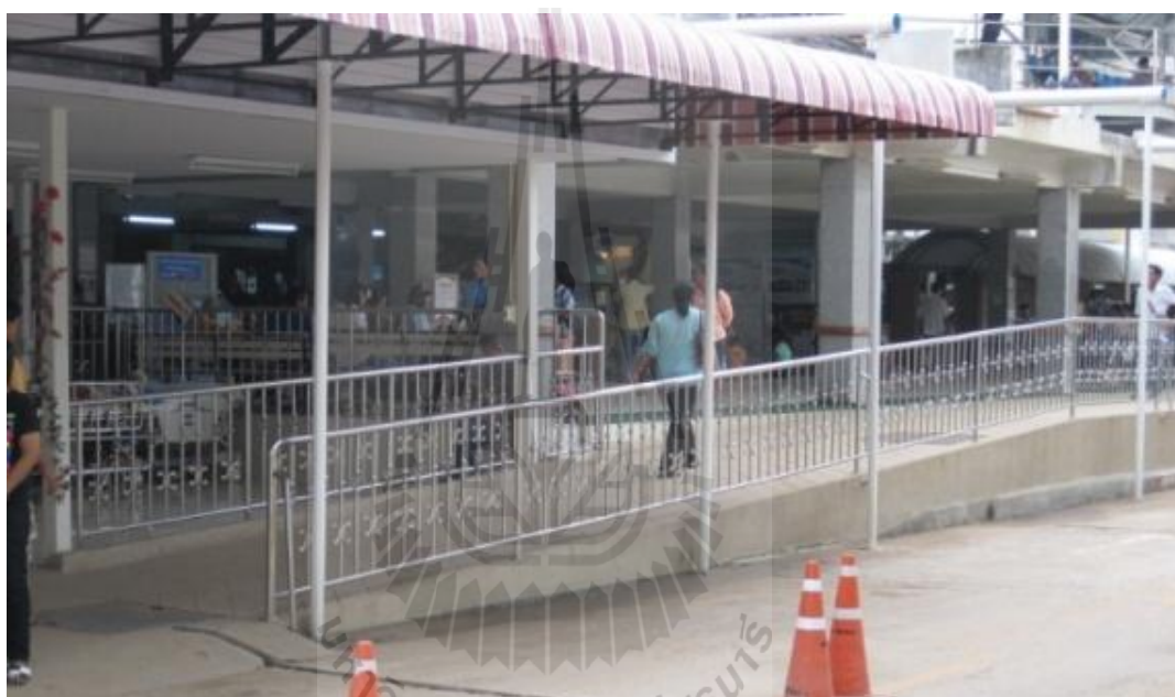
รูปที่ 4.10 ทางลาดด้านหน้าอาคารผู้ป่วยนอก (ทางเข้าหลัก)
