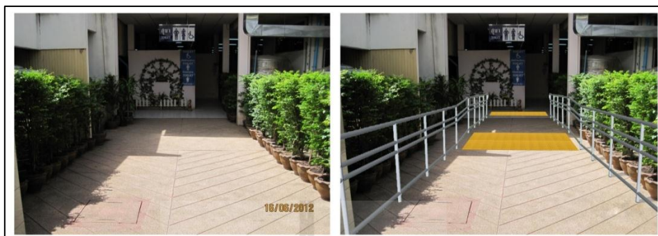
รูปที่ 4.39 เปรียบเทียบลักษณะของทางลาดสู่ห้องน้ำด้านหลังอาคารก่อนปรับปรุง (ซ้าย) และข้อเสนอแนะในการปรับปรุง (ขวา)
