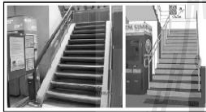
รูปที่ 2 เปรียบเทียบบันไดด้านหน้าอาคารก่อนปรับปรุง (ซ้าย) และข้อเสนอแนะในการปรับปรุง (ขวา)
