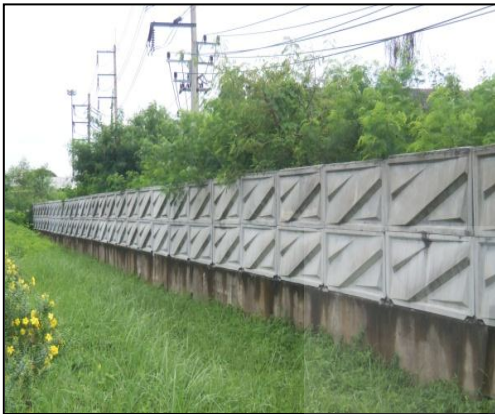
ติดตั้งบนกำแพงข้างไหล่ทาง
