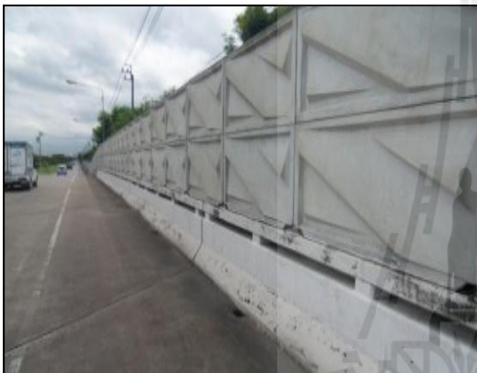
ช่องว่างบนขอบสะพาน
