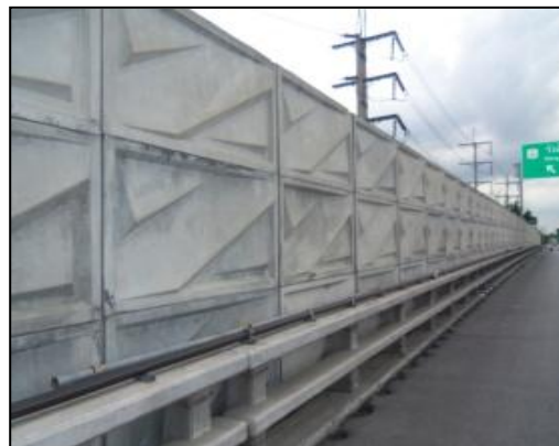
ติดตั้งบนสะพาน
