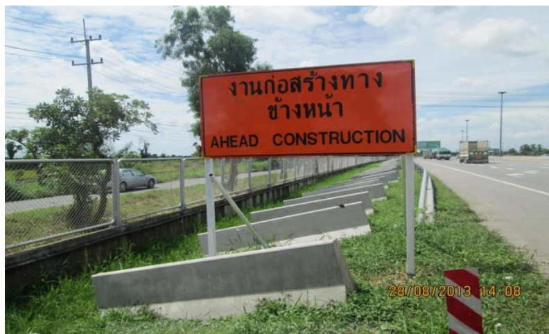
รูปที่ 2.2 การดำเนินการก่อสร้างยกระดับคันทางยังไม่แล้วเสร็จ
