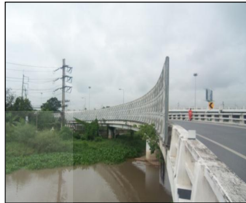
ติดตั้งบนสะพานต่างระดับ
