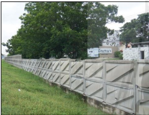
พื้นที่หมู่บ้านด้านหลังกำแพง
