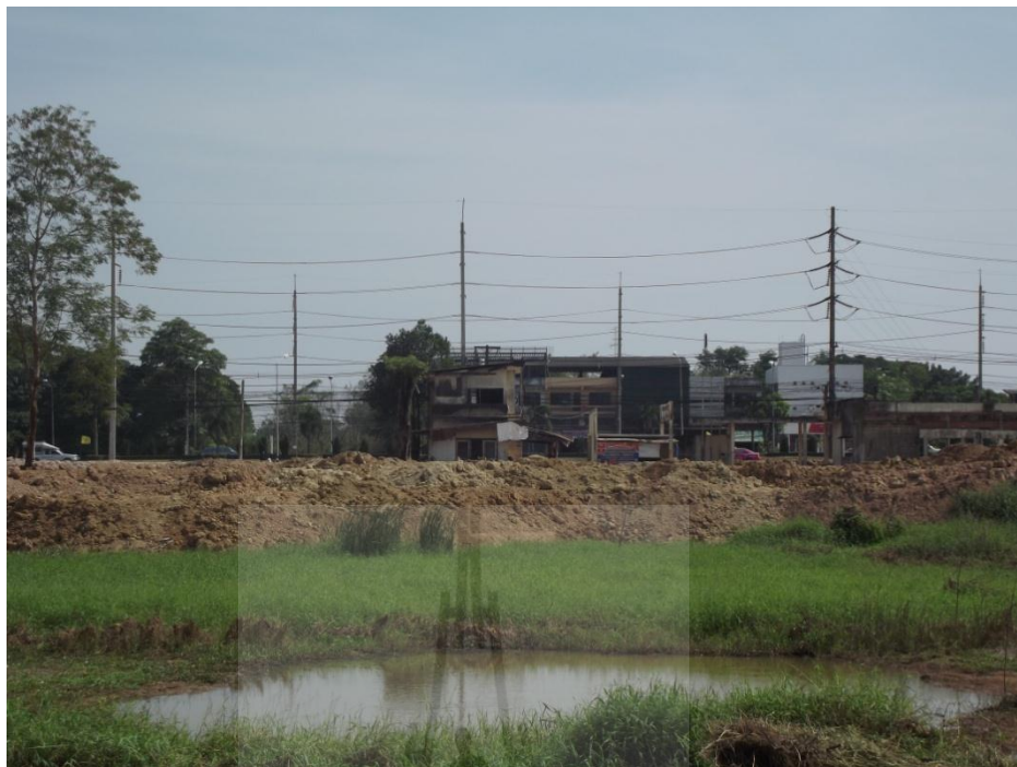
รูปที่ 1.1 การถมดินบริเวณพื้นที่เคยเป็นแหล่งรองรับน้ำธรรมชาติ
