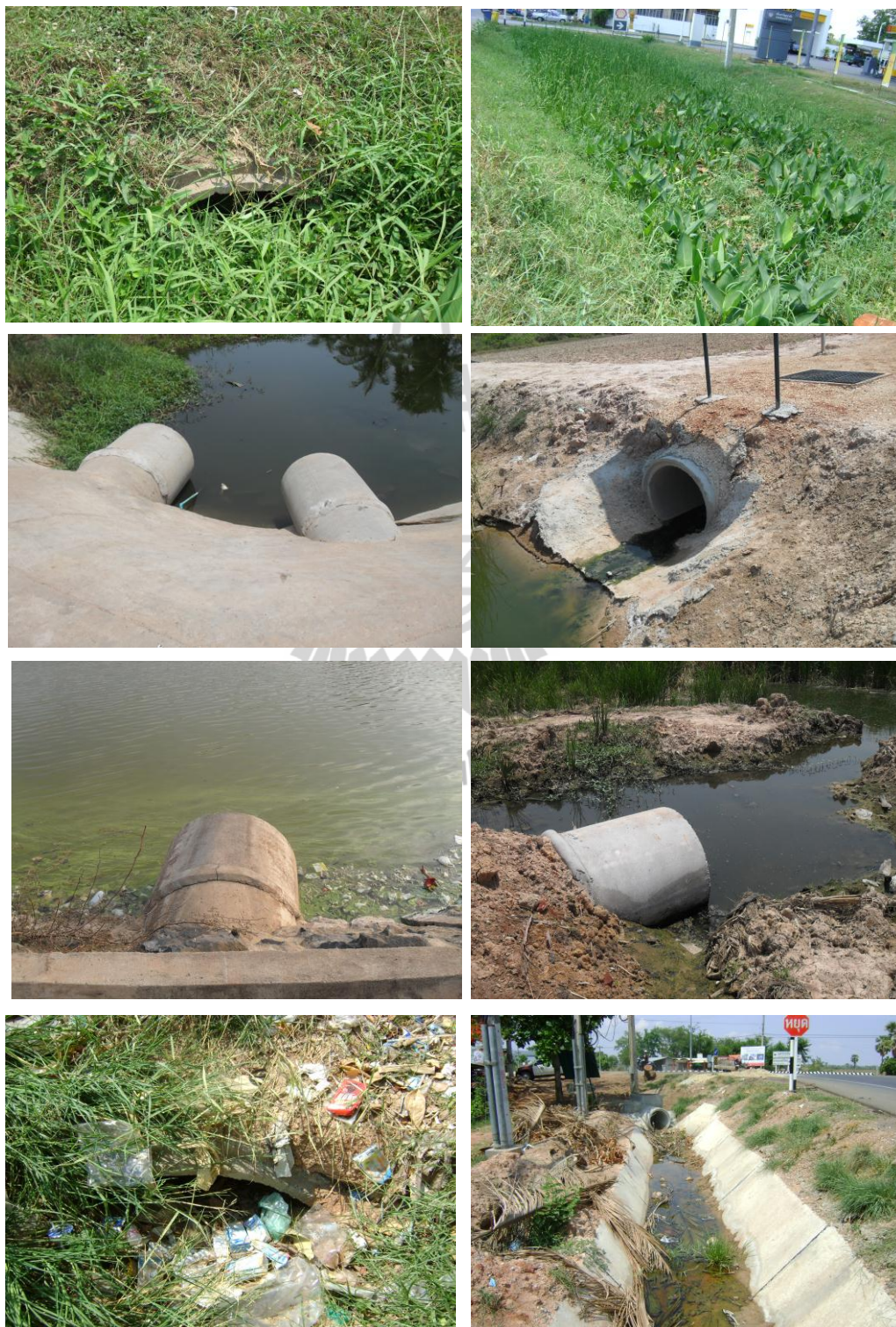
รูปที่ 4.6 สภาพการระบายน้ำบริเวณปลายท่อระบายน้ำในปัจจุบัน
