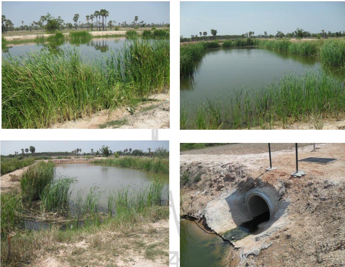
รูปที่ 5.2 พื้นที่ในการก่อสร้างระบบบำบัดน้ำเสีย 2
