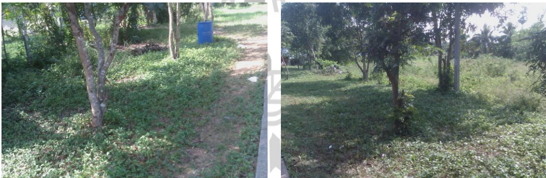
รูปที่ 3.9 บริเวณโครงการก่อสร้างปากประตูระบายน้ำและวางท่อระบายน้ำปัจจุบัน
