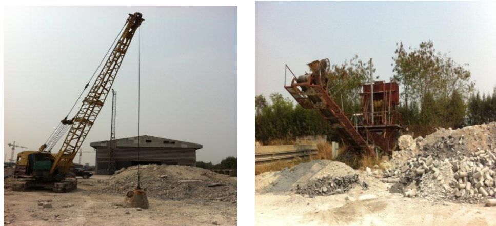
รูปที่ 3.10 เครื่องย่อยเศษคอนกรีต
