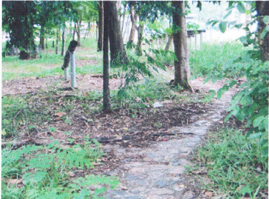
รูปที่ 2.1 สภาพถนนเก่าภายในสวนสุขภาพ
