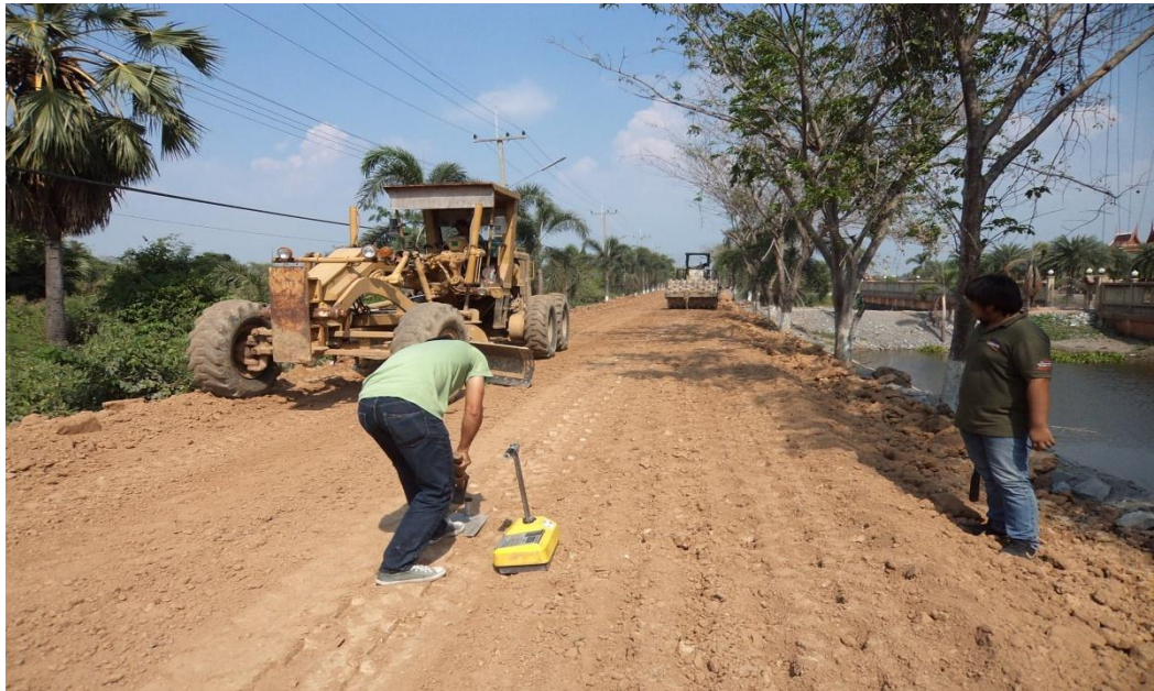
รูปที่ 3.2 การทดสอบความแน่นในสนามรอบที่ 8
