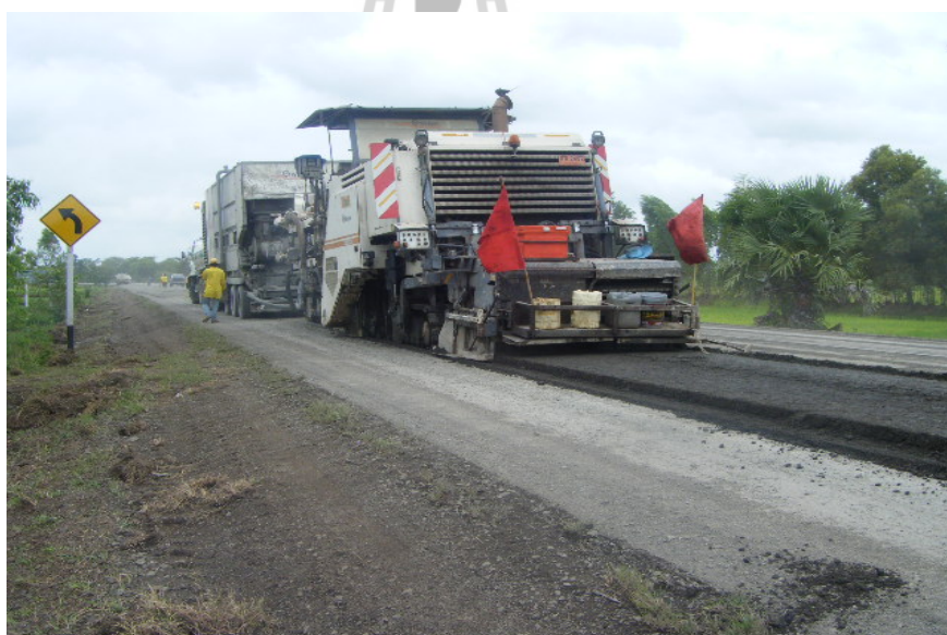
รูปที่ 1.2 เครื่องจักรขุดตัดผิวทางและพื้นทาง
