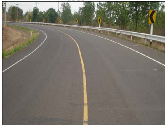
รูปที่ 3.8 หลังดำเนินการก่อสร้าง บริเวณทางโค้ง PI STA. 7+858.250
