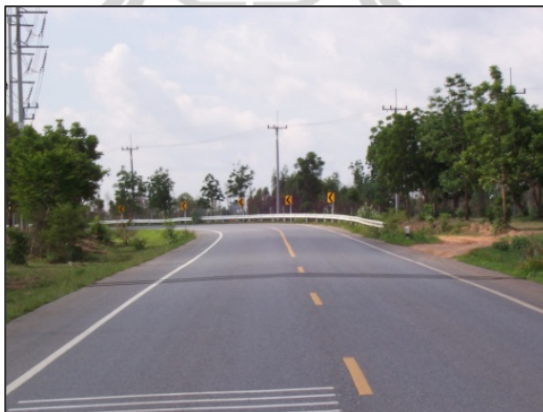
รูปที่ 3.3 ก่อนดำเนินการก่อสร้างบริเวณทางโค้ง PI STA. 5+288.850
