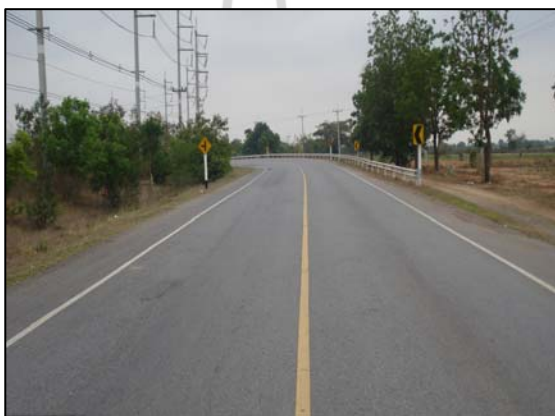
รูปที่ 3.5 หลังดำเนินการก่อสร้าง บริเวณทางโค้ง PI STA. 5+288.850
