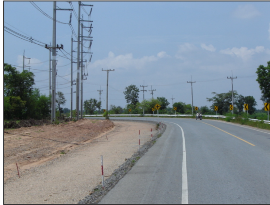
รูปที่ 3.7 ขณะดำเนินการก่อสร้าง บริเวณทางโค้ง PI STA. 7+858.250
