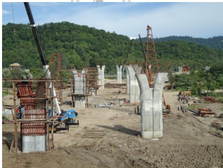
รูปที่ 9 งานก่อสร้างเสาตอม่อ
