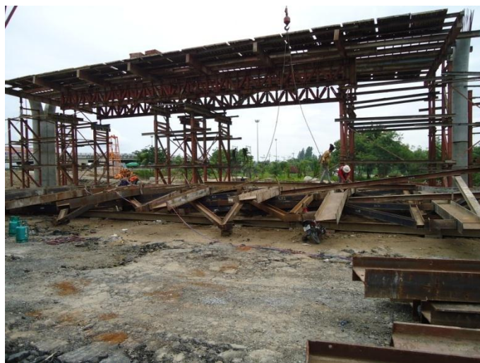
รูปที่ 10 งานตั้งนั่งร้านพื้นสะพาน
