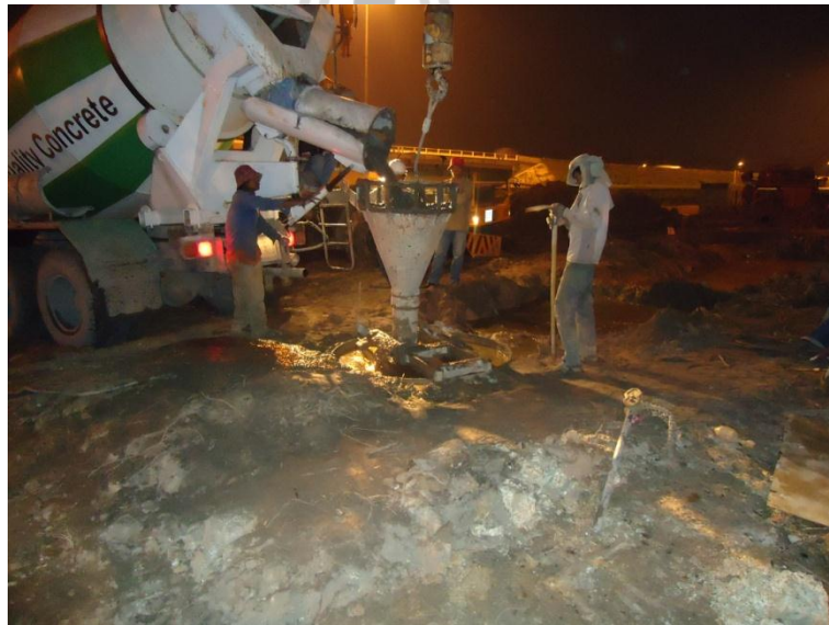
รูปที่ 7 งานก่อสร้างเสาเข็มเจาะ
