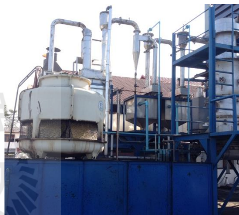
ซ. ถังรวบรวมน้ำเสีย (Buffer tank)
