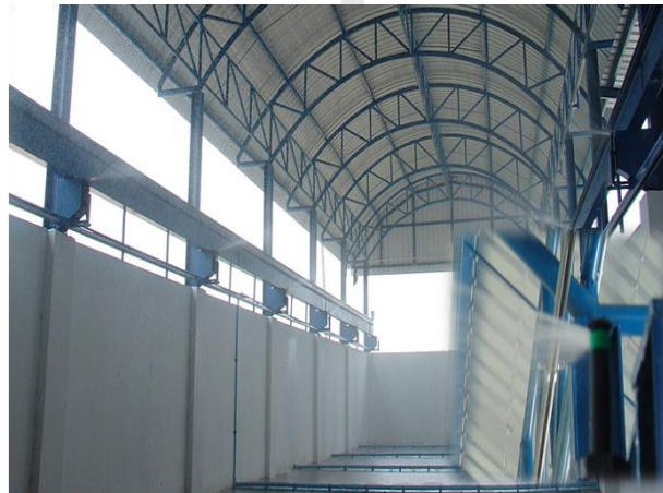
รูปที่ 4-9 การควบคุมความชื้นโดยใช้ระบบ Sprinkler
